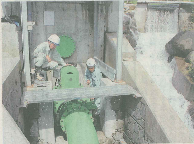
地場企業が開発し由布市庄内町野畑の用水路に設置された小水力発電所
